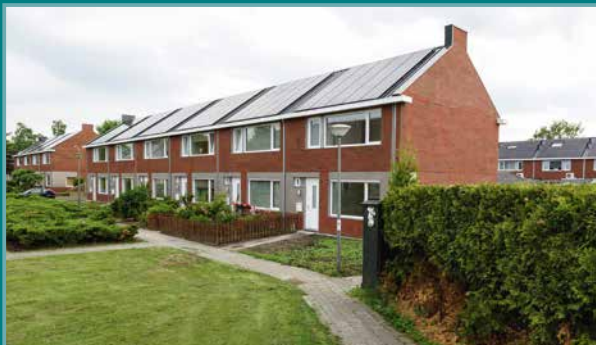
Hoppad Roden, NOM-renovatiewoningen
