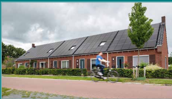
Heerdelaan Zuidlaren, NOM-levensloopbestendige woningen
