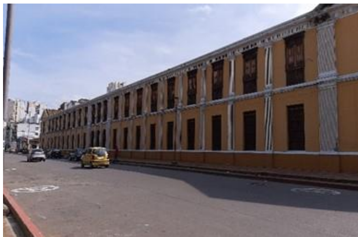
Figura 25. Foto Centro Cultural del Oriente, Barrio Centro, Comuna 15, Bucaramanga, Santander, Colombia.
