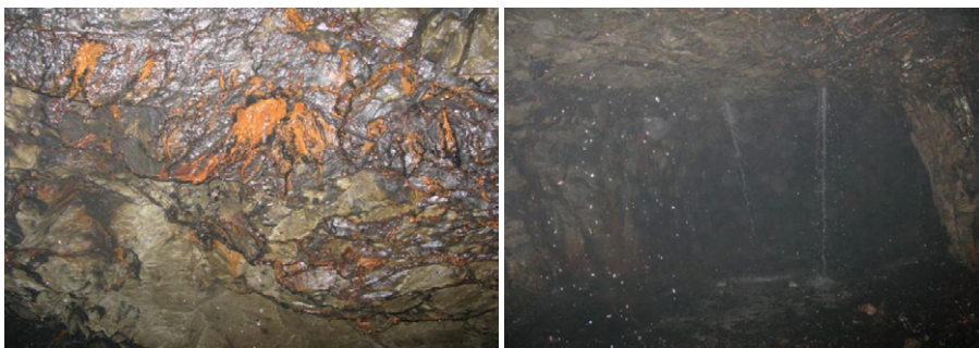
(1) Fissure rock mass
