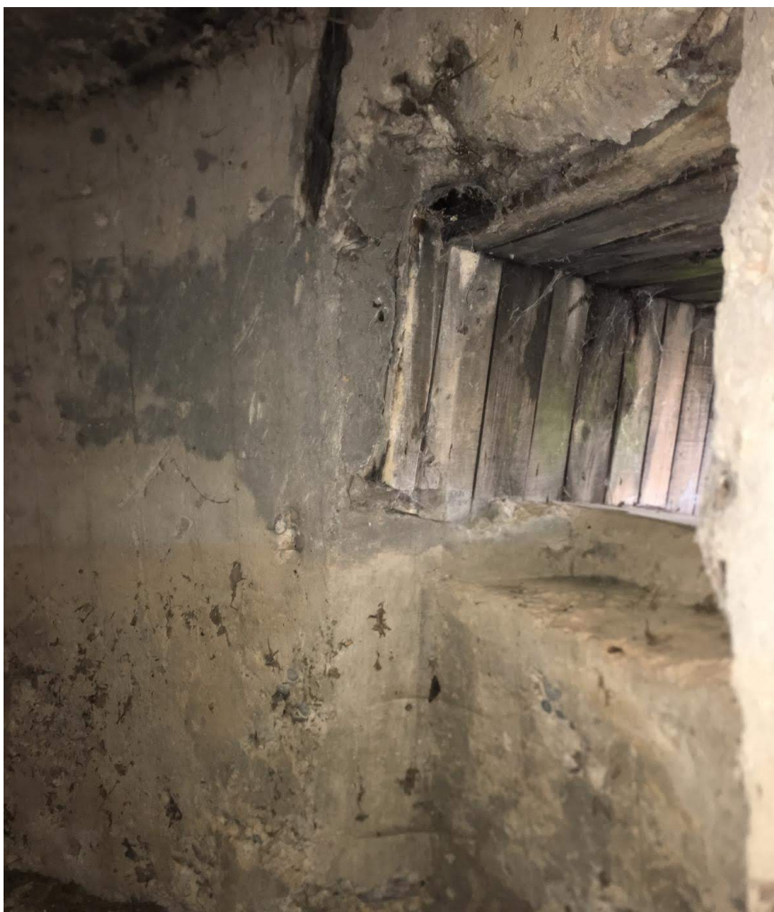
Figura 21. Fotografia de les espitlleres des de l'interior del niu de metralladora on es poden veure els taulons de fusta que les recobrien. Imatge: inèdita.
