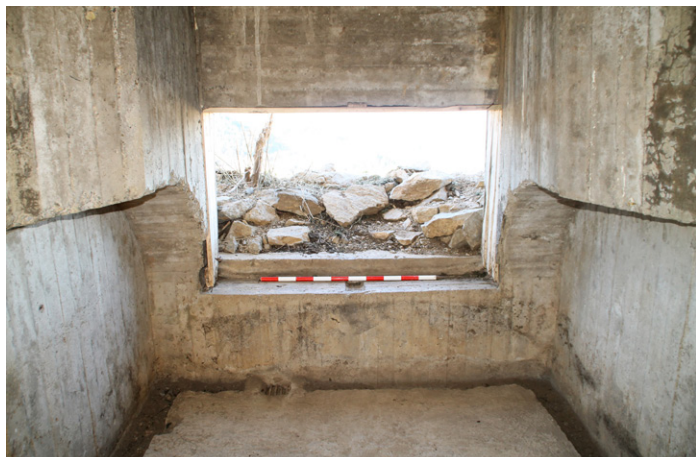
Fig. 4: Vista interior de l'espitllera (P1) i les obertures de les parets laterals (P2 i P8). Al sòl veiem la canalització d'aquest espai i el petit desaigüe. Orientació SE-NO. FONT: equip del Passat Més Recent
