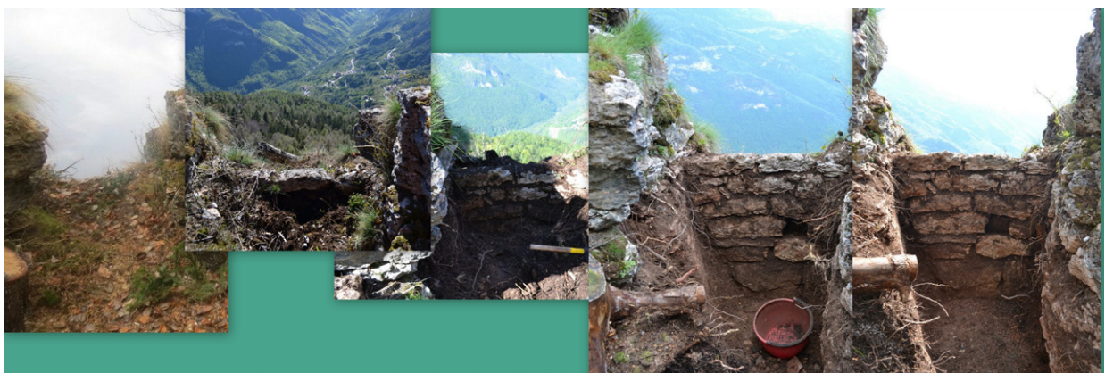
Fig. 17: Fases de excavación y recuperación de dos Stützpunkte (puntos fortificados)
