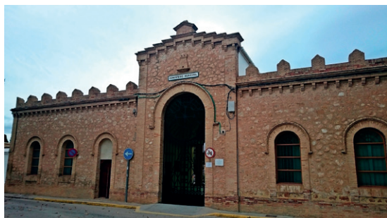
Façana del Cementeri Municipal, Paterna. Foto: V. Gabarda
