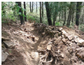
Fig. 4: Tramo de trinchera intervenido en el paraje de Mareamendi. Foto: J. Buces
