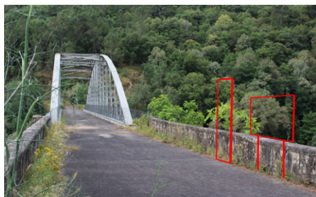
Fig. 7: ejemplo de propuesta de señalización y panel informativo en el Puente de Castro do Miño. FUENTE: propia.
