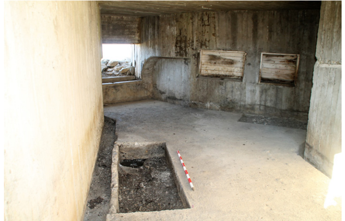
Fig. 5: Interior de l'estructura estança principal. Veiem el petit canal que ressegueix les parets de l'estructura, així com els dos dipòsits. Al fons l'espitllera i dues fornícules. FONT: equip del Passat Més Recent
