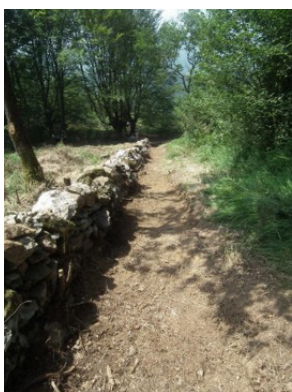
Fig. 5: Muro de delimitación en el paraje de Zarateaitz. Foto: J. Blanco
