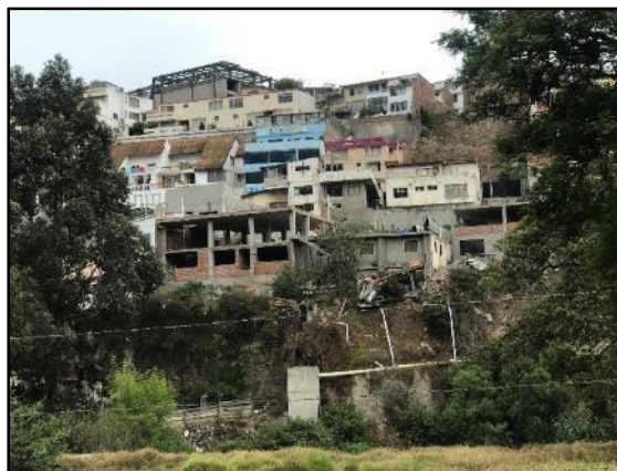
Fotografía 1. Viviendas cerca a la orilla del río Ambato
