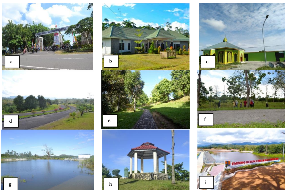
Gambar 1. Pembangunan fisik Kebun Raya Massenrempulu Enrekang: (a) Pintu gerbang, (b) Kantor pengelola, (c) Masjid dan MCK, (d) Jalan hotmix dan boulevard, (e) Jalan gicok, (f) Jalan row 12 dan beton, (g) Embung 2, (h) Gazebo, (i). Embung 3
