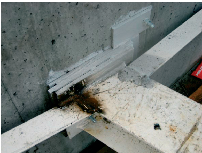
Fot. 4. Zamocowanie stalowego rygla w ścianie żelbetowej. Photo 4. Joint of steel and reinforced concrete construction.
