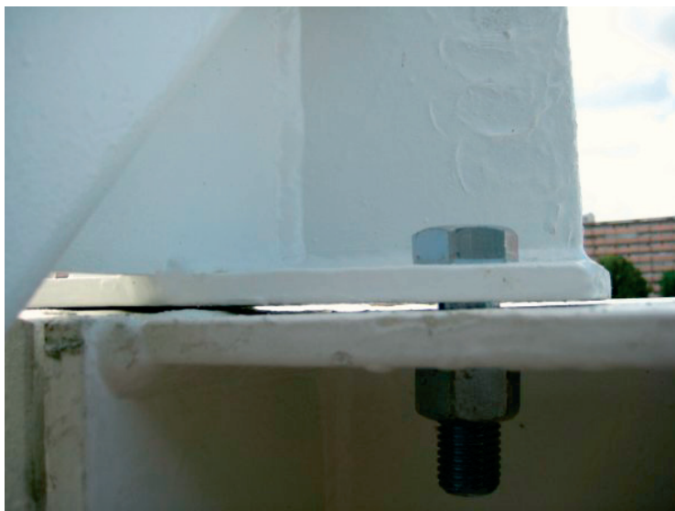
Fot. 2. Oparcie płatwi na dźwigarze. Photo 2. Support of the roof beam on the girder.
