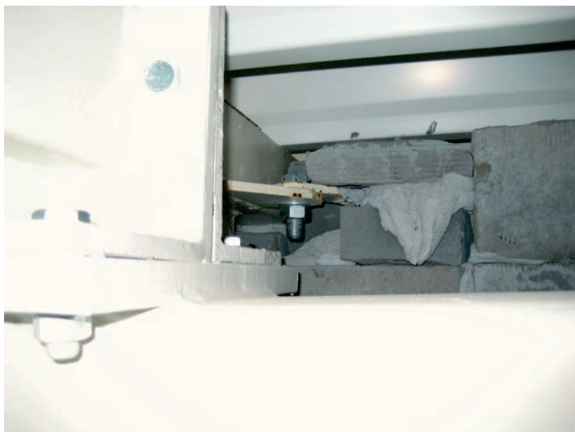
Fot. 7. Widok zabetonowanego stężenia od strony dźwigara. Photo 7. View of blocked bracing from the girder's side.
