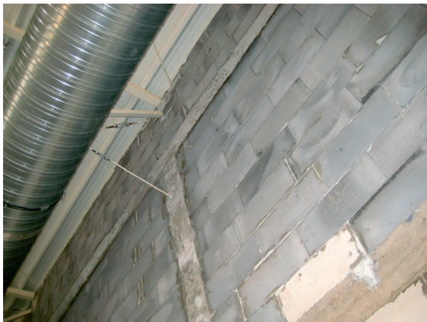
Fot. 6. Widok zabetonowanego stężenia od strony płatwi. Photo 6. View of blocked bracing from the roof beam's side.
