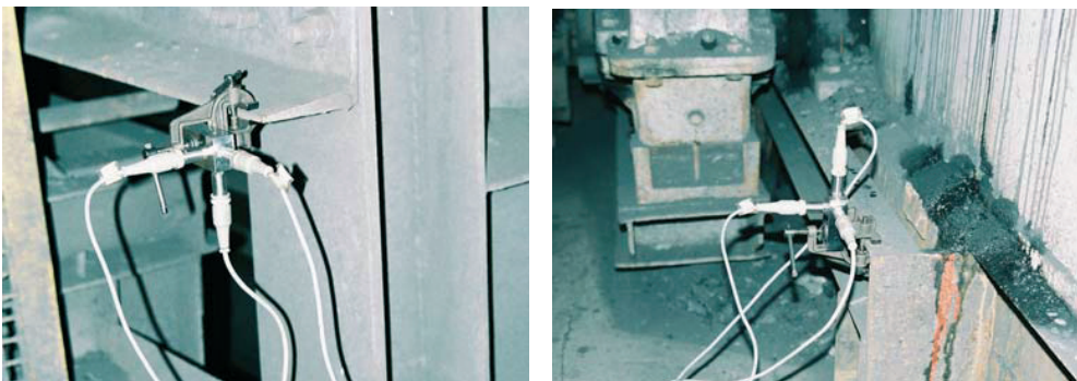
Rys. 1. Sposób zamocowania akcelerometrów. Fig. 1. Accelerators constraining fastening.
