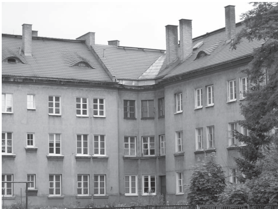
Rys. 15. Budynki typu IV i V Ulica Piłsudskiego.
