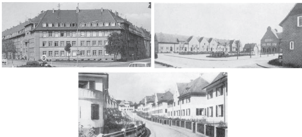
Rys. 21,22,23. Przykładowe wybudowane w latach dwudziestych XX wieku niemieckie zespoły mieszkaniowe o architekturze w twórczy sposób kontynuującej tradycyjne wzory. Od lewej: kwartał zabudowy w Münster z lat 1925-1927; osiedle Am Lindenplatz w dzielnicy Laatzten w Hanowerze, – architekt Paul Wolf; osiedle domów wielorodzinnych w Dreźnie z około 1925 roku. Źródło: Miller-Lane [1].
