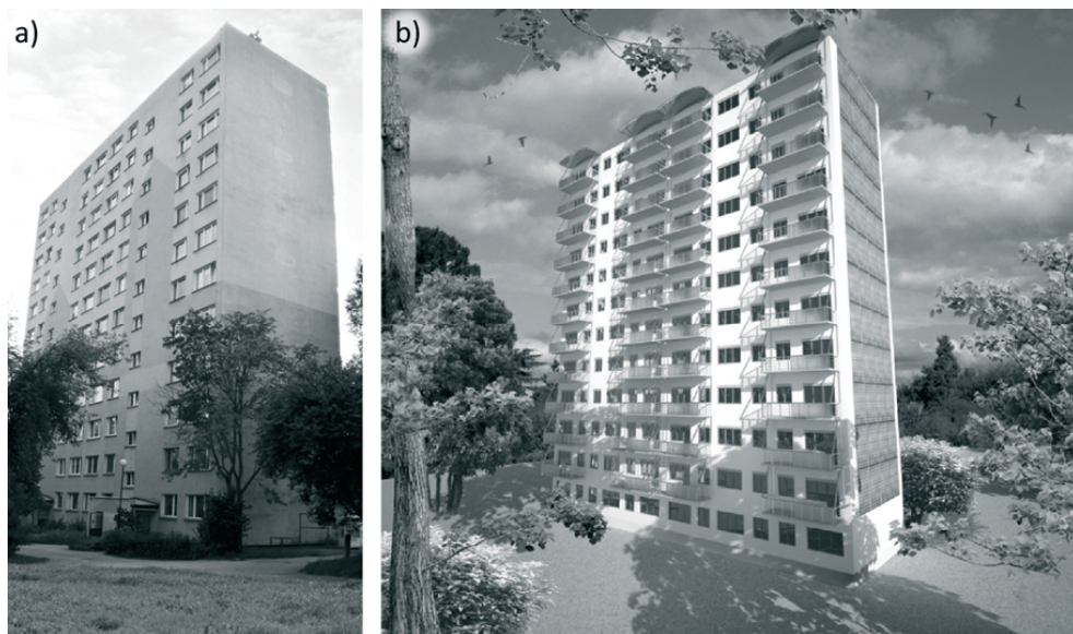
Rys. 7. Analizowany wysoki budynek wielkopłytkowy, a) stan obecny, narożnik północno-wschodni, b) wizualizacja MDN/R+E, narożnik południowo-zachodni.
