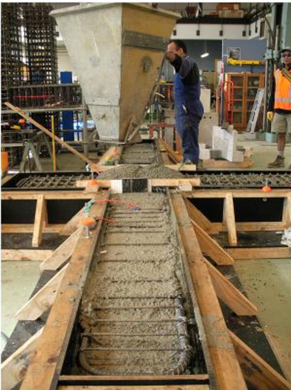
(g) Concrete pouring
