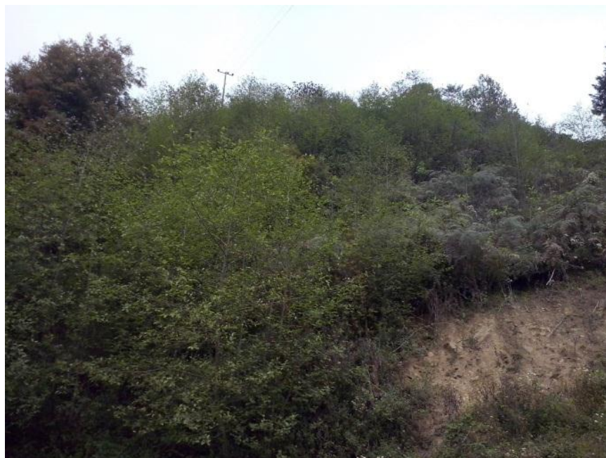
Figura 29. Revegetación de talud de carretera con ilite en Taxco, Tetela de O.
