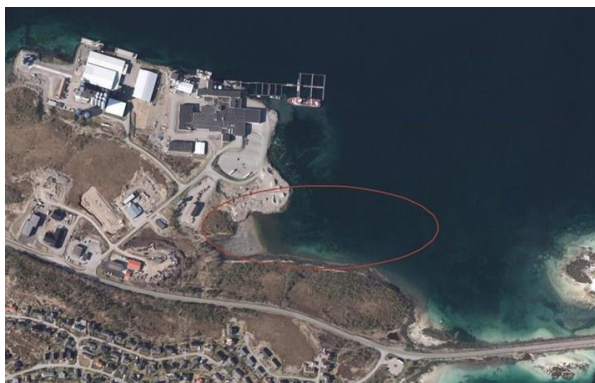
Figur 3. Planområdet for søknaden fra Nordlaks Eiendom om utfylling i sjø i Klubbvika ved Børøya industriområde. Deler av Storskjæret ses i høyre bildekant. Kilde: Fylkesmannen i Nordland .
