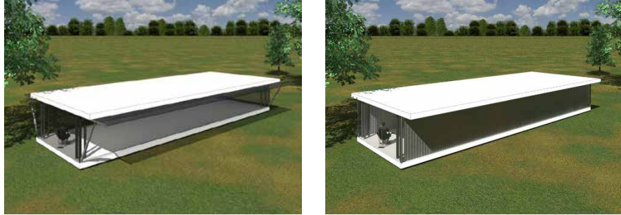
FIGUUR 8.2 Het paviljoen voorzien van een glasgevel die kan worden opengeklapt (links) en van gordijnen om de bouwfysische kwaliteiten te verbeteren.
