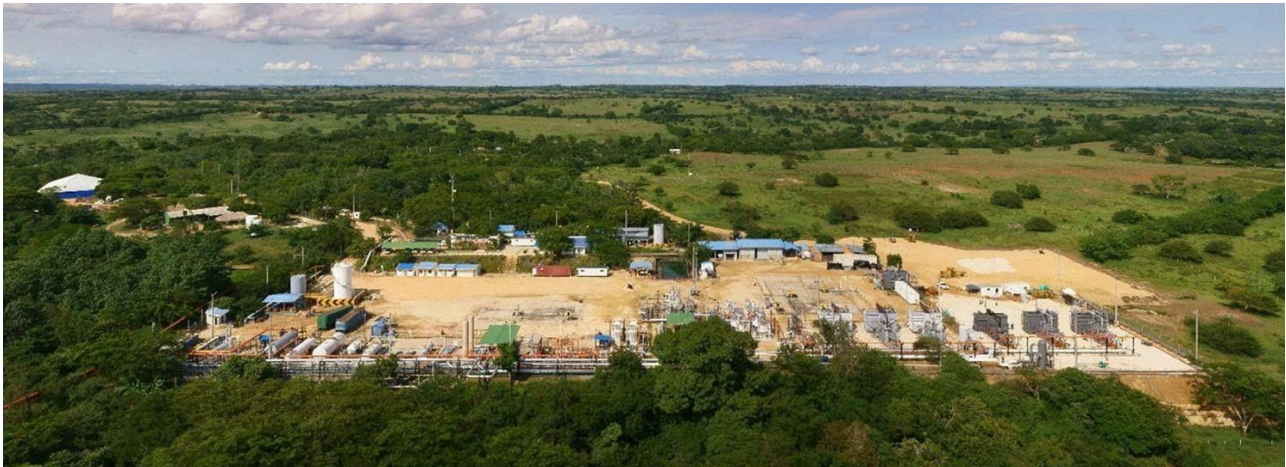
Ilustración 1. Bloque La Creciente (vista panorámica).
