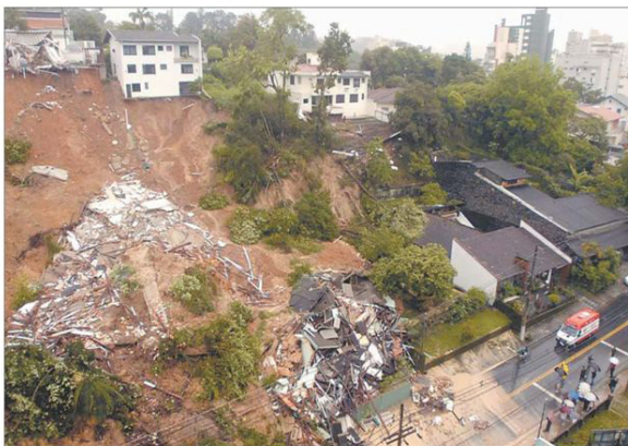
FIGURA 1. Desmoronamento na Rua Hermann Huscher, Blumenau. 24/11/2008.
