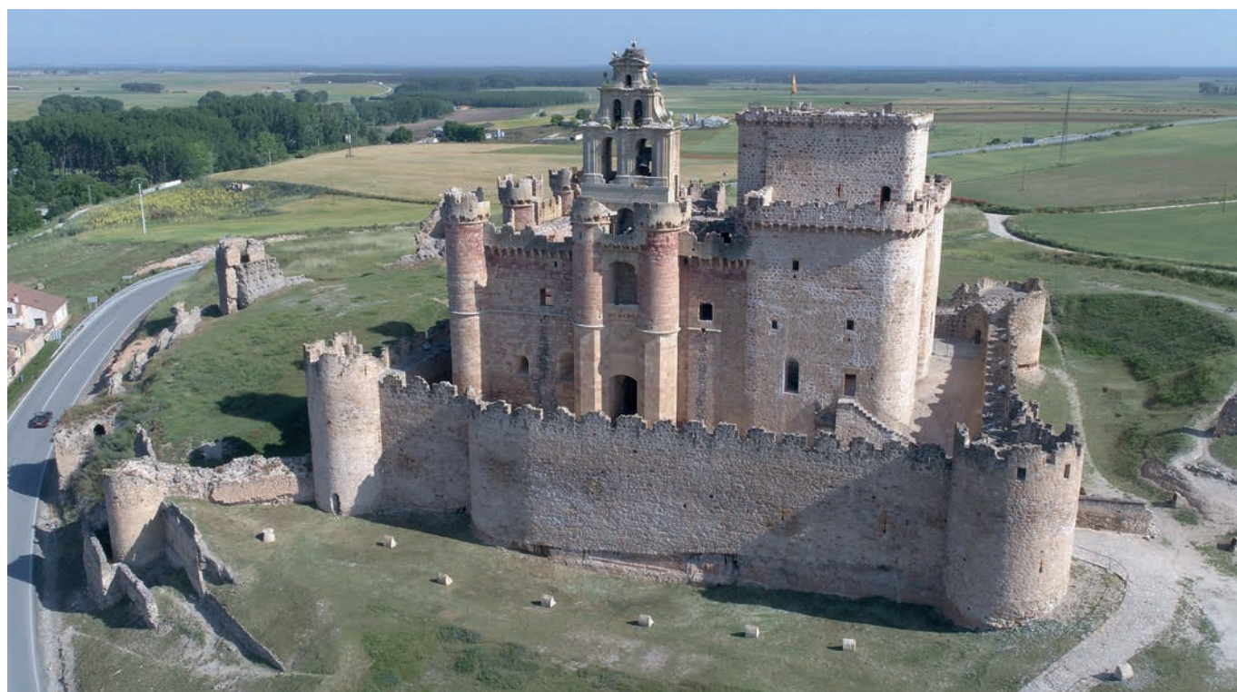
Figura 1. Vista aérea del conjunto arquitectónico desde el sur, rodeado por las ruinas de la cerca exterior a las que le une una coracha en primer plano (izquierda). Fotografía de Carlos Puerto.
