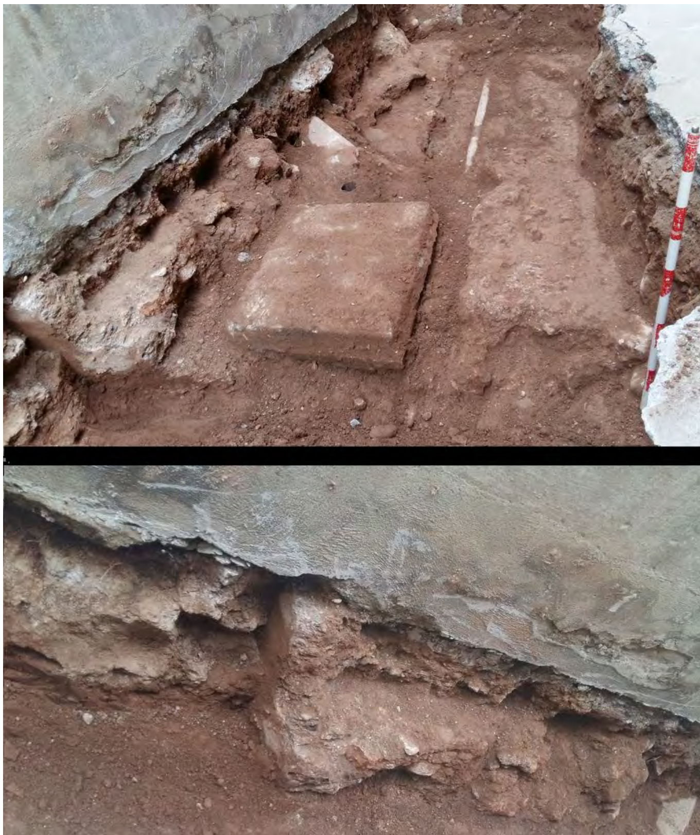
Figura 15. (1) Cimentación de la torre de la calle Zaragoza. (2) Detalle del paramento del encofrado de la cimentación de la torre bajo las casas. Fotografía: autores.
