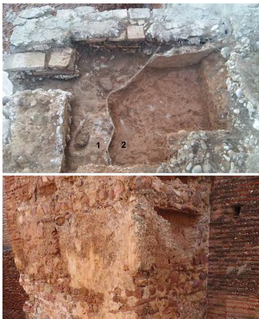
Figura 13. (1) Parte superior de la torre de la calle San Pascual, 26-28. Las obras de mampostería se llevaron a cabo en el siglo XIX (1, 1). El relleno original se conserva en la mitad oriental (1, 2). (2) Detalle del paramento exterior de la torre donde se observan las verdugadas de mampuesto. Fotografía: autores.
