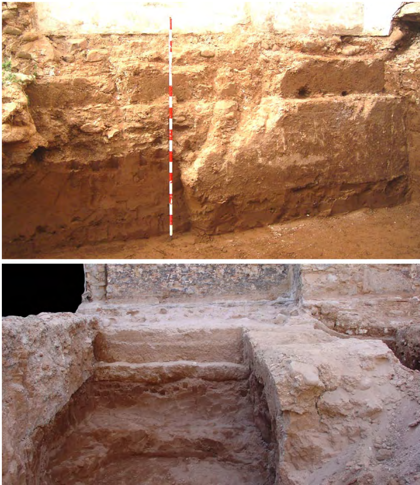
Figura 8. (1) Detalle de la cimentación de la muralla en la calle Mayor, 26. (2) Al fondo, cimientos de la muralla; en primer plano, base de encofrado y cimentaciones de edificios de época bajomedieval. Fotografía: autores.
