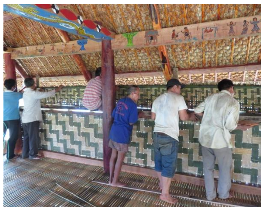
Hình 19. Lắp phen cho vách và giá để đồ Ảnh chụp bởi các thành viên dự án
