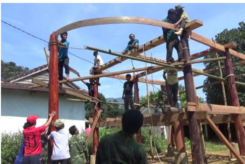
Hình 12. Dựng cột chái và vành hồi Ảnh chụp bởi các thành viên dự án
