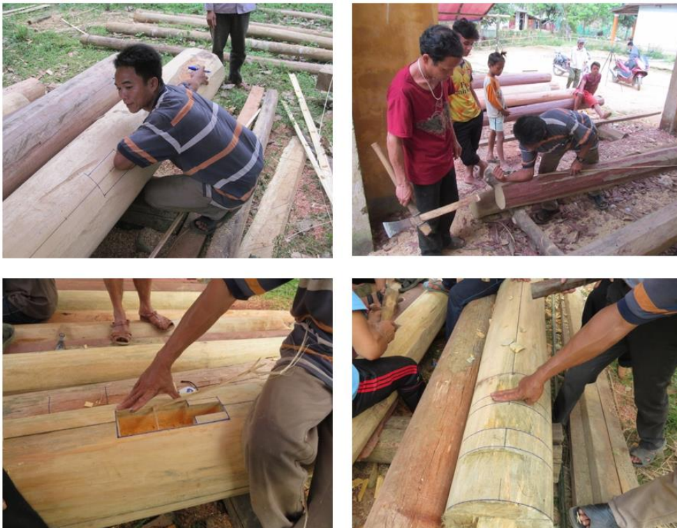
Hình 4. Áp dụng các đơn vị cơ thể trong gia công cấu kiện Gươl ở thôn A Ka Ảnh chụp bởi các thành viên dự án
