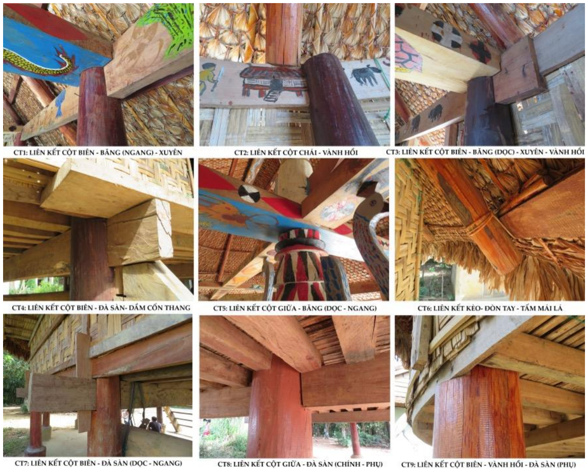
Hình 20. Các chi tiết liên kết các cấu kiện chính ở Grol thôn A Ka
