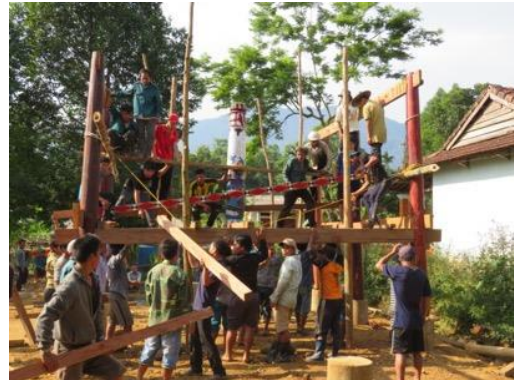
Hình 11. Dựng cột biên – đà sàn chính (dọc – ngang) Ảnh chụp bởi các thành viên dự án
