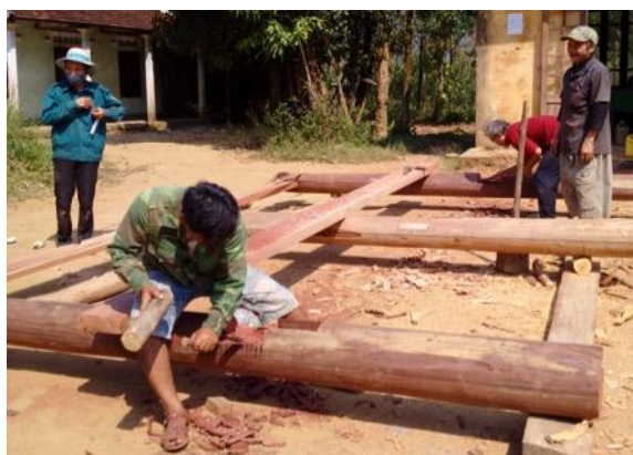
Hình 6. Gia công chi tiết mộng cột-băng-xuyên Ảnh chụp bởi các thành viên dự án
