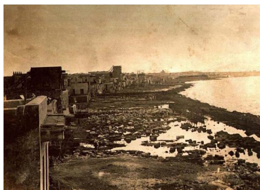
Figura 1. Insalubridad y proximidad de las construcciones en La Habana frente a las costas del litoral de Cuba. (De las Cuevas, J., 2006).
