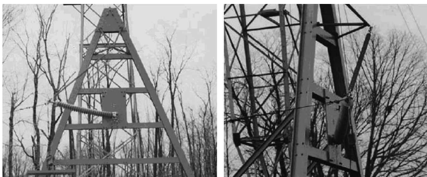
Abb. 4-23 Blockieren einer Isoliertraverse beim Versuch [Bernstorf 2008]
