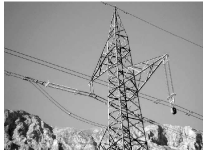
Abb. 2-6 Tragabspannung
