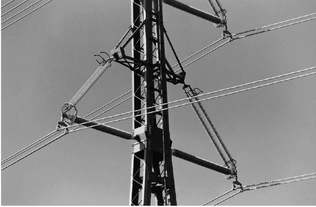
Abb. 3-5 Horizontalstützer in einer Isoliertraverse
