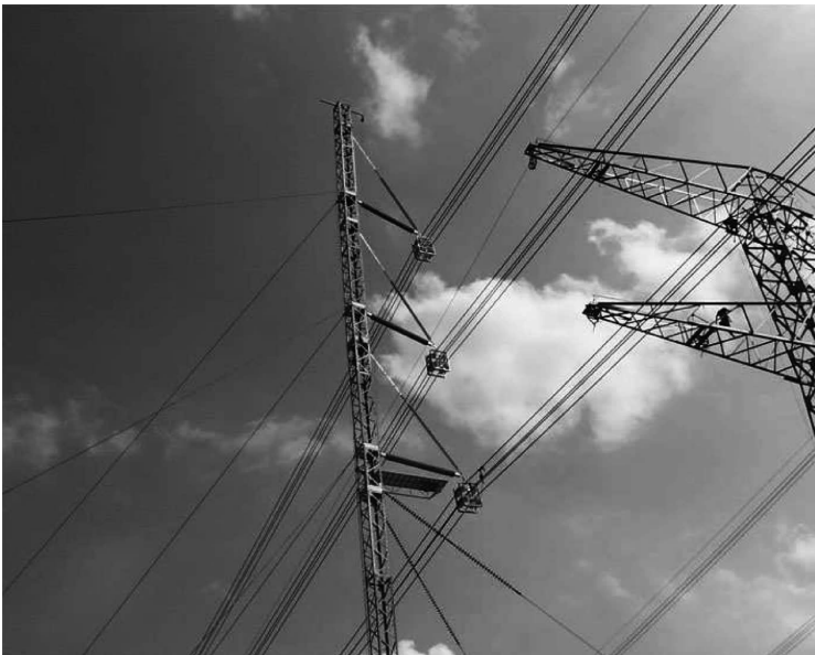
Abb. 4-33 Notgestänge mit Isoliertraversen bei der Umlegung des Viererbündels
