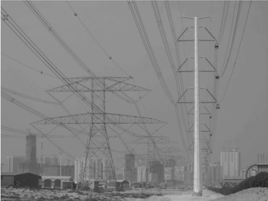
Abb. 4-34 Die neue 420 kV Kompaktleitung (während dem Seilzug) neben der bestehenden konventionellen 420 kV Leitung, rechts im Bild die Stadtautobahn, im Hintergrund die Skyline von Dubai
