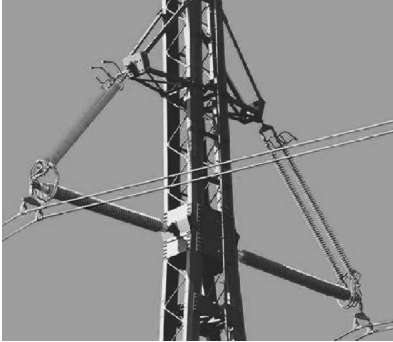
Abb. 2-7 420 kV Isoliertraverse
