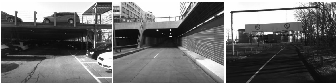
Abbildung 8-7 Ausgewählte Hindernisse. Links: Einfahrt zu einem Parkdeck; Mitte: Tunnelleinfahrt; Rechts: Freihängende Warnschilder und -baken
