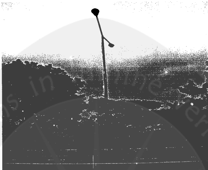
Gambar penerangan jalan jenis Lucalok 250 Watt
