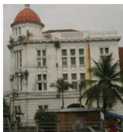
Gambar 1: bangunan cagar budaya gedung singa, yang dibiarkan kosong dan terlantar, bangunan banyak ditumbuhi tanaman liar, yang berpotensi untuk merusak bangunan Sumber: Pengamatan lapangan
