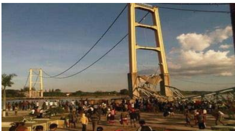
Gambar 6. Dugaan konstruksi yang kurang kuat
