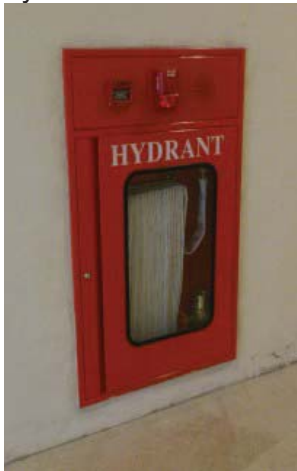
Gambar 6. Hidrant box ruangan
