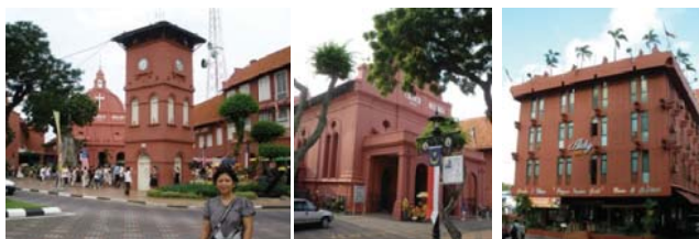
Gambar 6: Bangunan warisan budaya milik pemerintah ditandai dengan warna cat merah. Walaupun sebenarnya sedikit menyalahi dengan aturan konservasi bangunan international, karena telah merubah aslinya Sumber: Pengamatan lapangan
