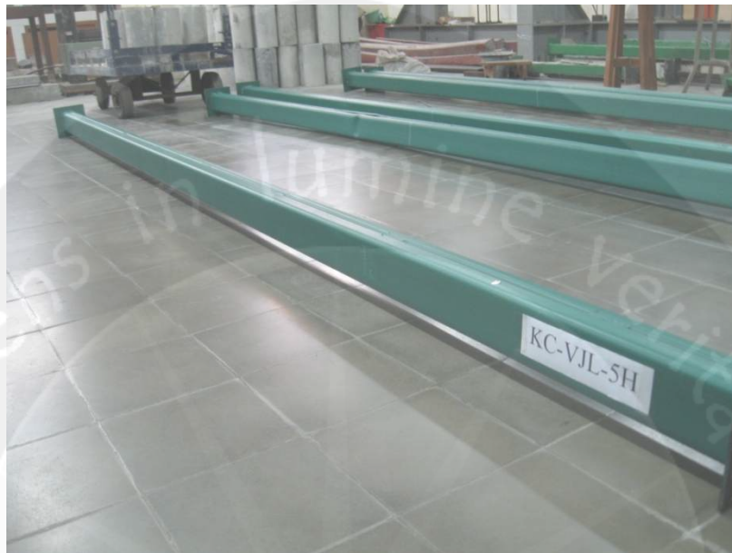
Kolom Baja Profil C Gabungan dengan Variasi Jarak Las 5H Setelah Pengujian
