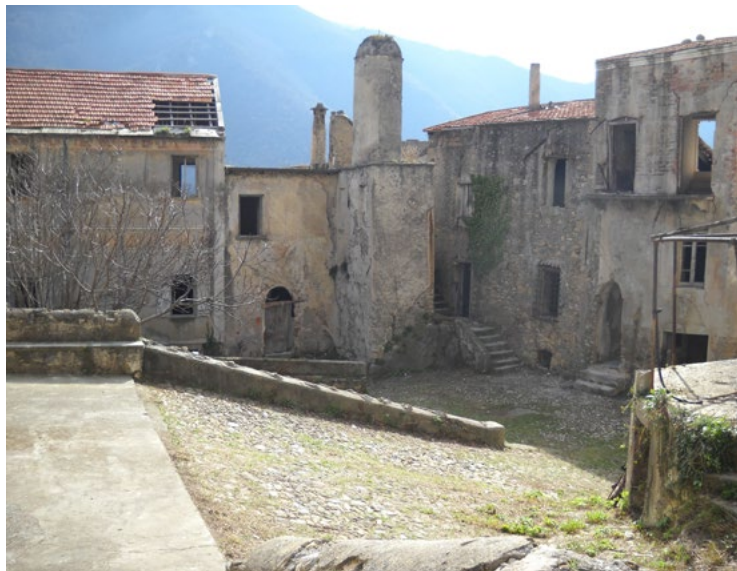
Figure 1-2. Balestrino (Savona). Vedute del paese abbandonato nel 1953 a seguito di un movimento franoso che si registrava fin dal secolo precedente (foto A. Mazzucchelli, A. Nobile, 2012).
