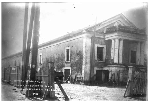
Fig. 5. Almacén de recibo de cargas del Depósito de Villanueva. La Habana. Archivo Fotográfico del Ministerio de la Construcción. Agosto 2013.
