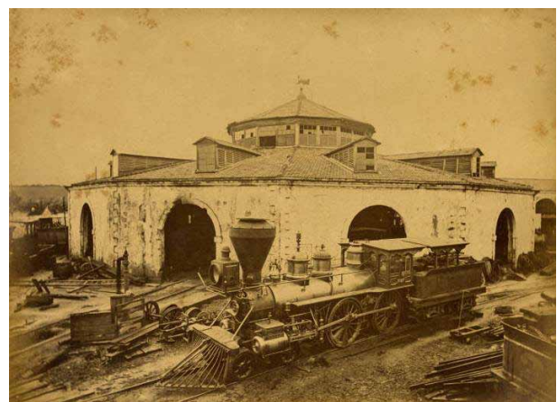
Fig. 4. Casa de máquinas del Ferrocarril de Sabanilla. Cortesía del Dr. Ercilio Vento Canosa, Historiador de la ciudad de Matanzas. Diciembre 2013.
