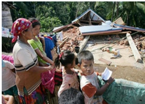
Gambar 1. Foto kerusakan bangunan akibat gempa bumi 12 September 2007
