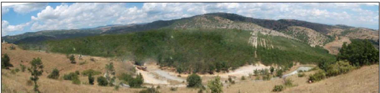
Сл.10.10 - Состојба и рекултивирана состојба на предната страна од браната на одлагалиштето на флотациска жаловина
