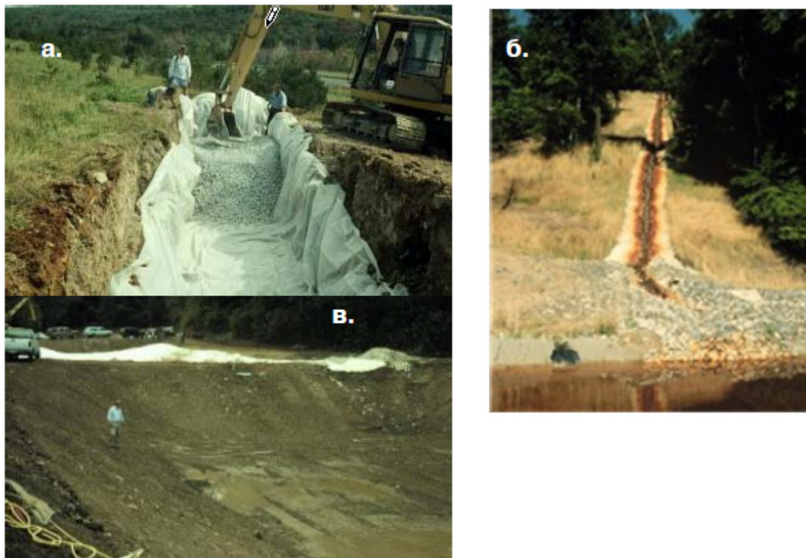
Сл. 10.3 а) безкислороден-затворен варовнички канал; б) отворен варовнички канал; в) варовничко езеро Picture 10.3 a) without an oxygene –closed limestone channel; b) an open limestone channel; c) a limestone lake.
