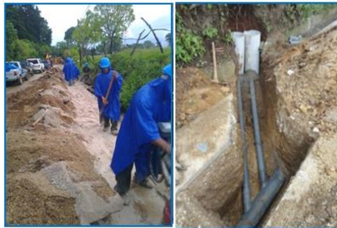
Figura 9. Introducción de tubería
