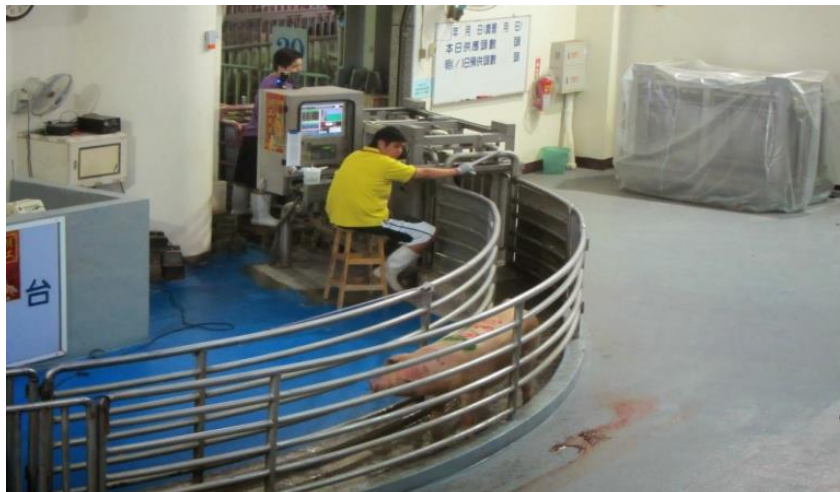
Figura 21. Barandas con hierro tubular
