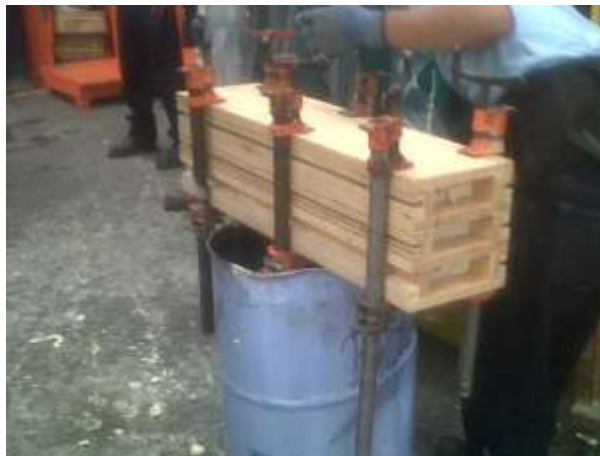
Imagen V. Mullions en los moldes de madera que se les ejerce presión con las manivelas
