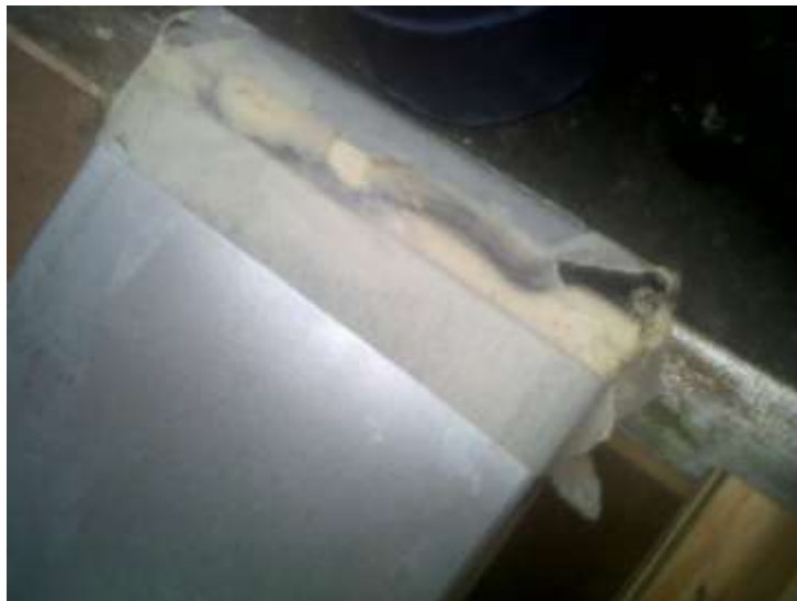
Imagen III. Espuma rígida de poliuretano en el mullion luego del proceso del espumado a 25 °C
