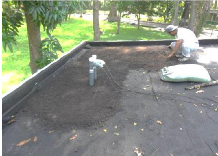
Figura 49. Colocación de tierra I
