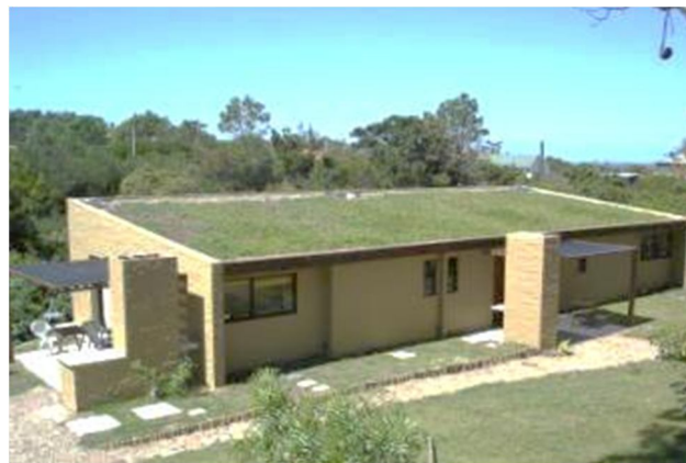
Figura 7. Techo verde tipo extensivo instalado
