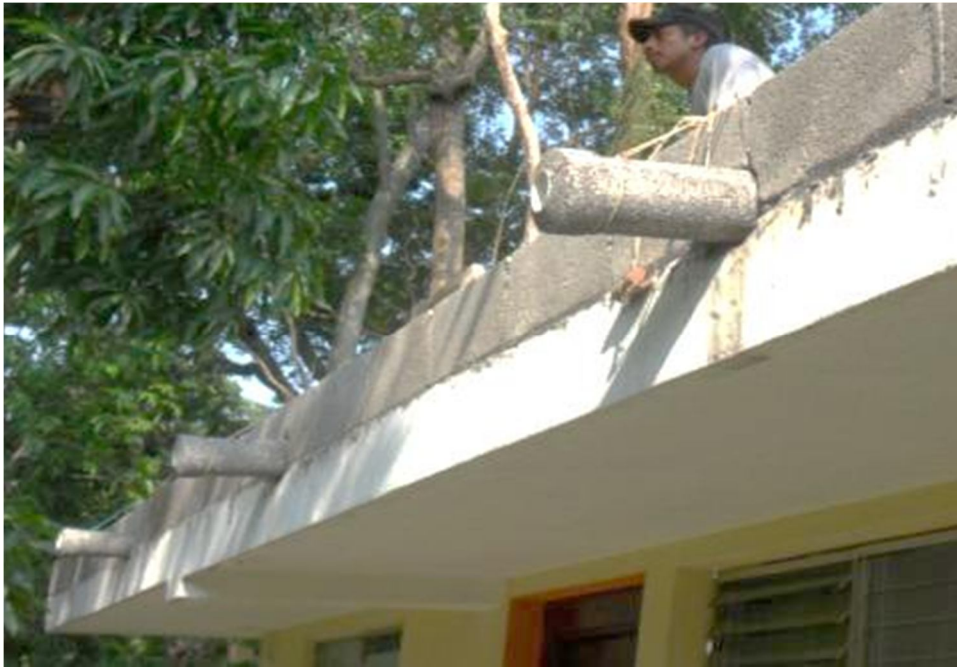
Figura 32. Colocación de descargas de agua pluvial y de riego
