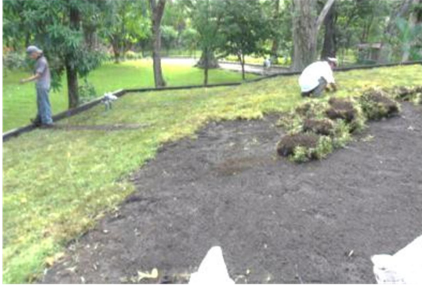
Figura 53. Colocación de tepes de grama I
