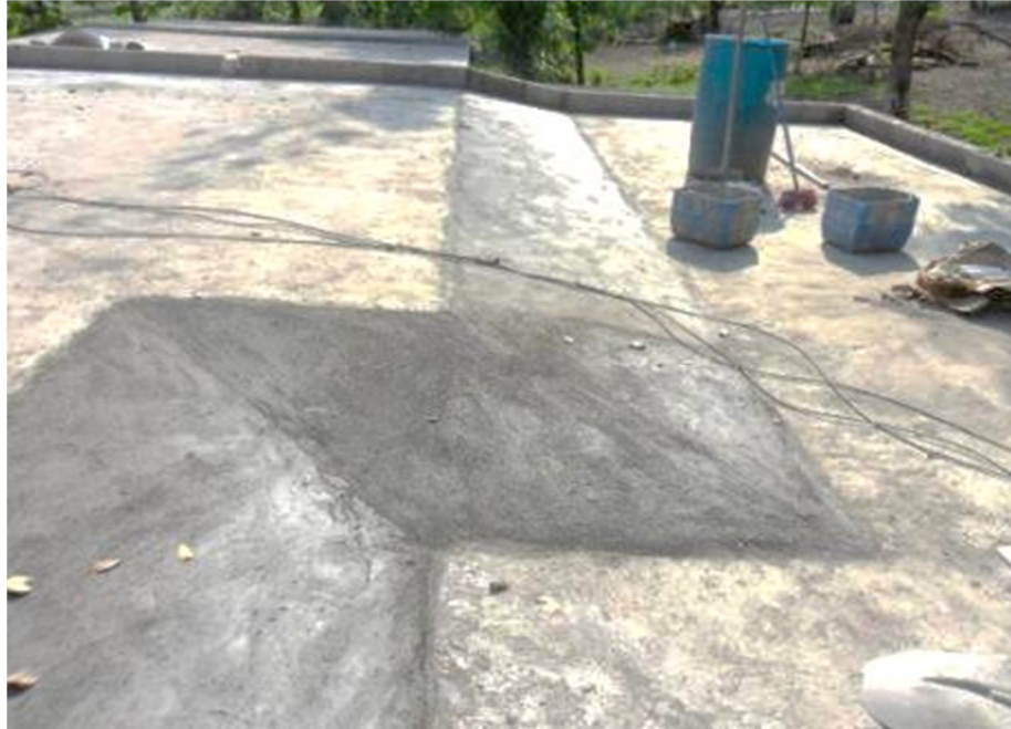
Figura 31. Corrección de diferencias de nivel en la losa
