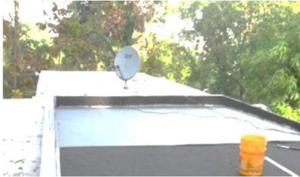
Figura 9. Instalación de manto de PVC impermeabilizante
