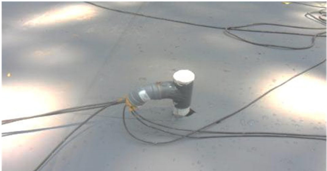
Figura 34. Aislamiento de conexiones por encima de la instalación
