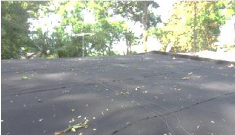
Figura 12. Geotextil colocado por encima del manto drenante
