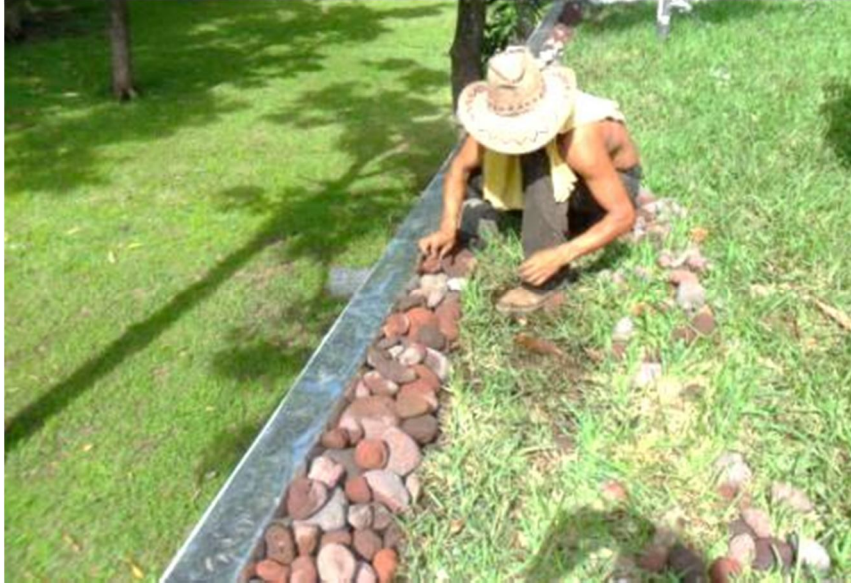
Figura 56. Acabados finales a la instalación
