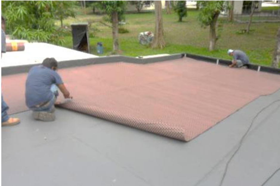
Figura 47. Colocación del manto drenante II
