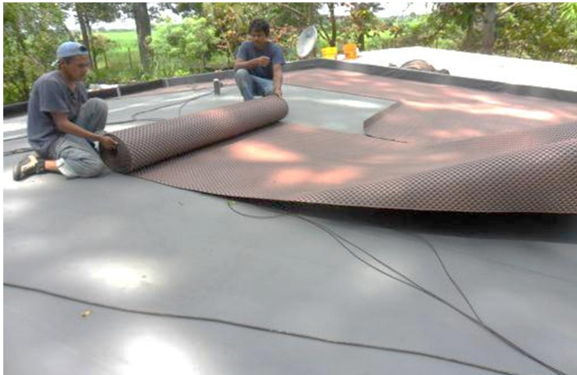
Figura 46. Colocación del manto drenante I
