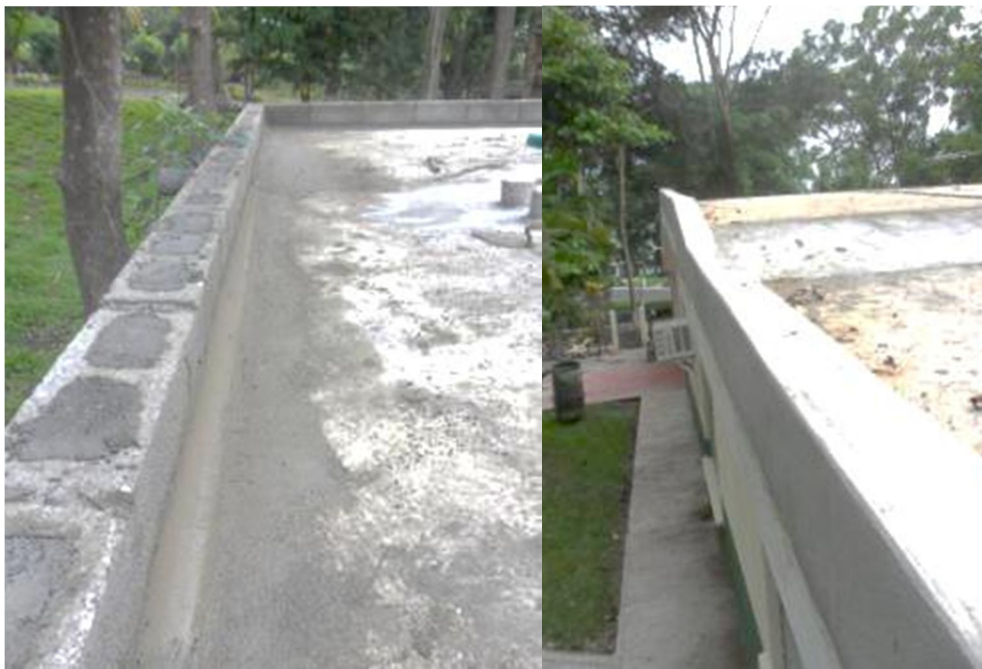
Figura 35. Acabados finales al área a instalar
