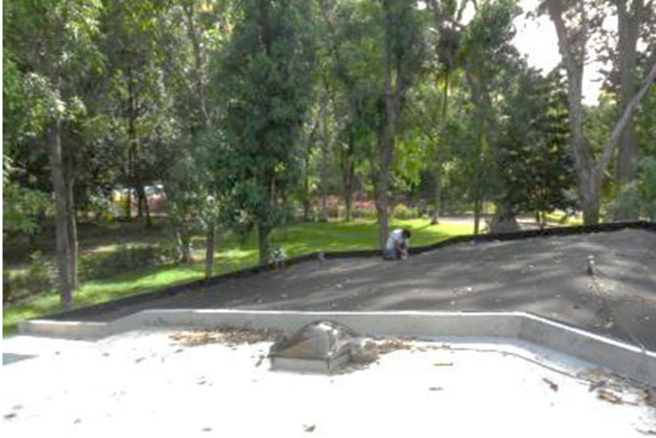
Figura 48. Colocación de geotextil
