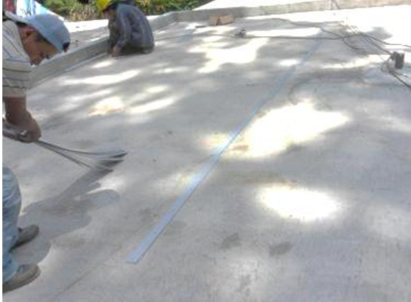
Figura 37. Colocación de bandas de anclaje en la losa II
