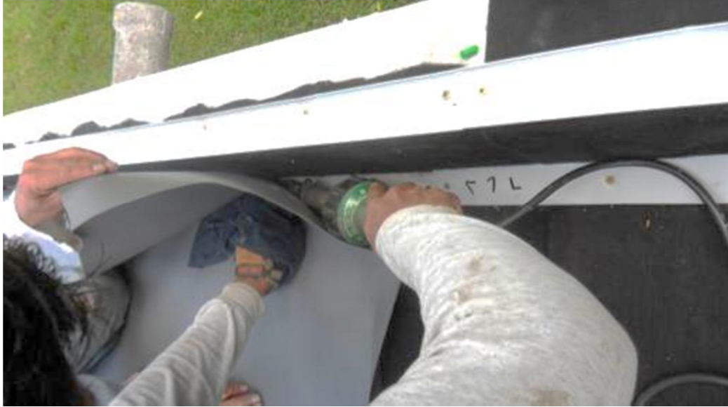
Figura 42. Colocación de manto impermeabilizante de PVC II
