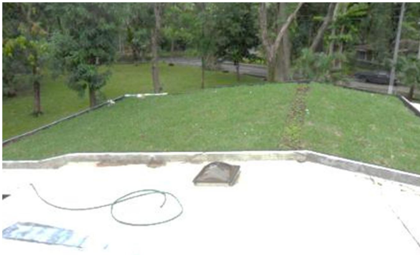
Figura 57. Techo verde tipo extensivo ya instalado
