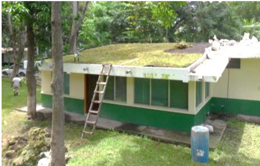
Figura 54. Colocación de tepes de grama II
