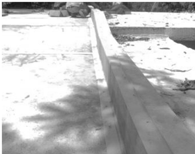
Figura 36. Colocación de bandas de anclaje en la losa I
