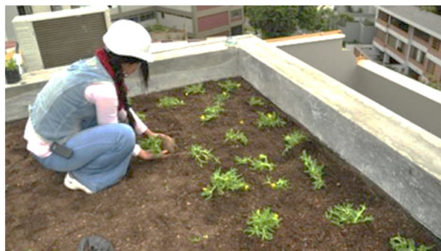
Figura 13. Colocación de capa de tierra y vegetación
