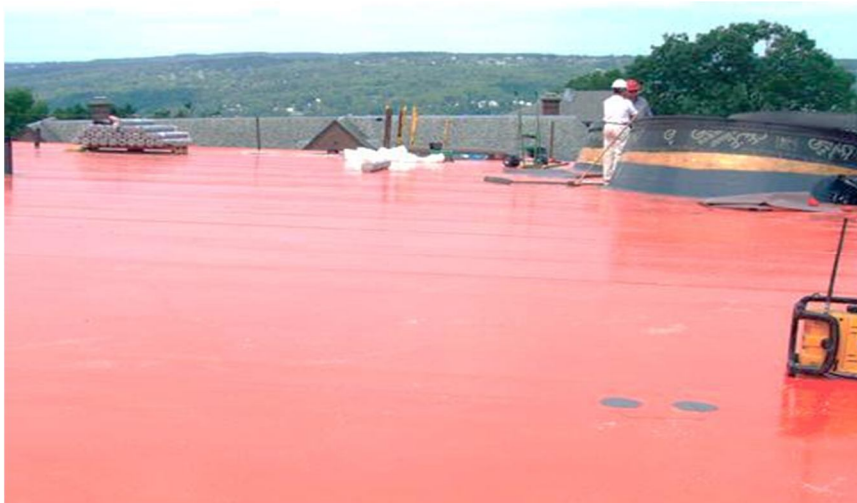
Figura 22. Membrana impermeabilizante de techo verde tipo intensivo
