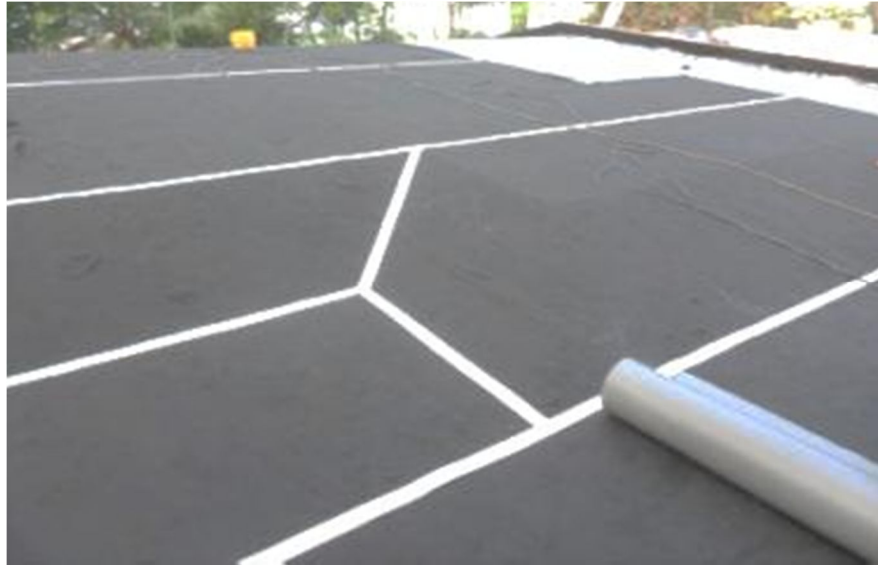
Figura 39. Proceso inicial de instalación de manto impermeabilizante I
