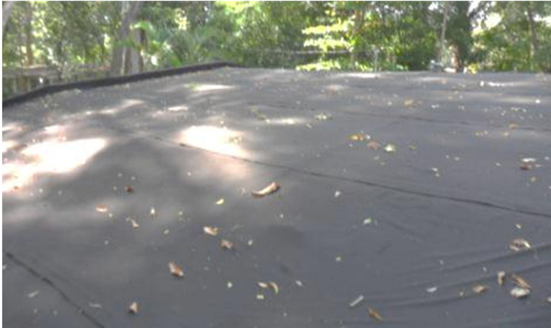
Figura 38. Colocación de colchón para evitar daños en manto impermeabilizante
