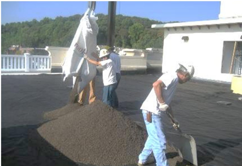
Figura 24. Proceso de colocación de tierra orgánica
