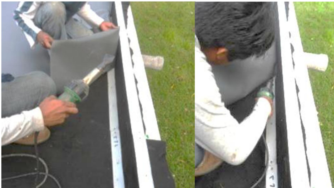
Figura 41. Colocación de manto impermeabilizante de PVC I
