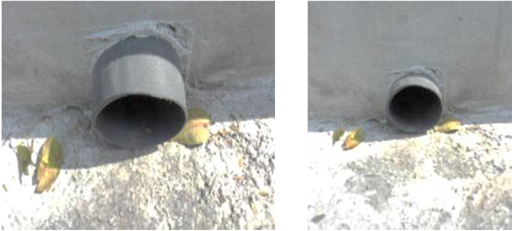
Figura 45. Colocación de impermeabilizante en descargas de agua
