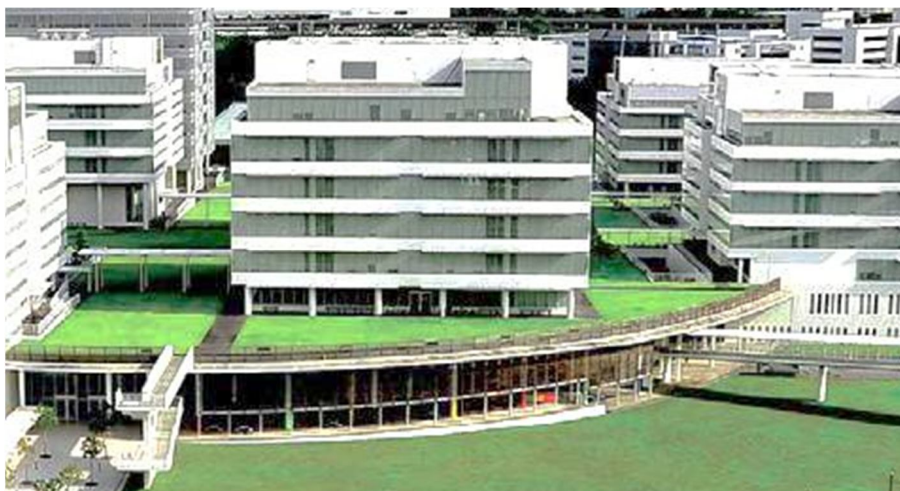
Figura 16. Instalaciones realizadas de techos tipo extensivo I
