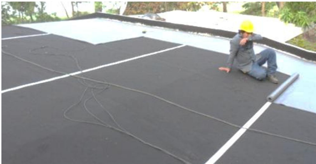
Figura 40. Proceso inicial de instalación de manto impermeabilizante II
