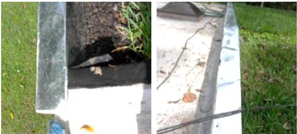
Figura 55. Colocación de protección perimetral en el borde
