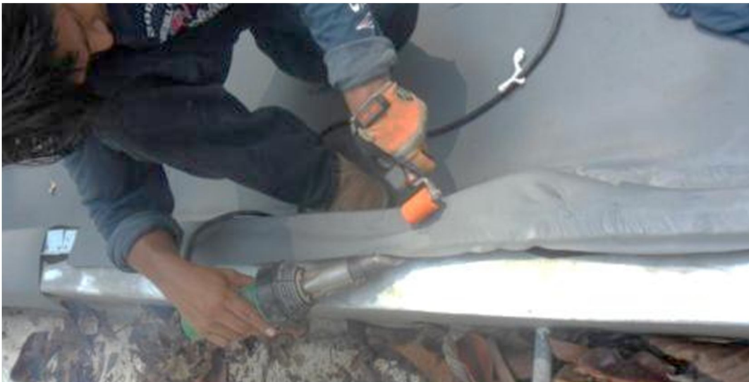
Figura 43. Colocación de manto impermeabilizante en bordes
