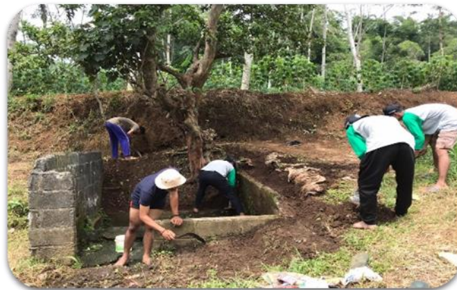
Gambar 1. Pembersihan lingkungan sumur
