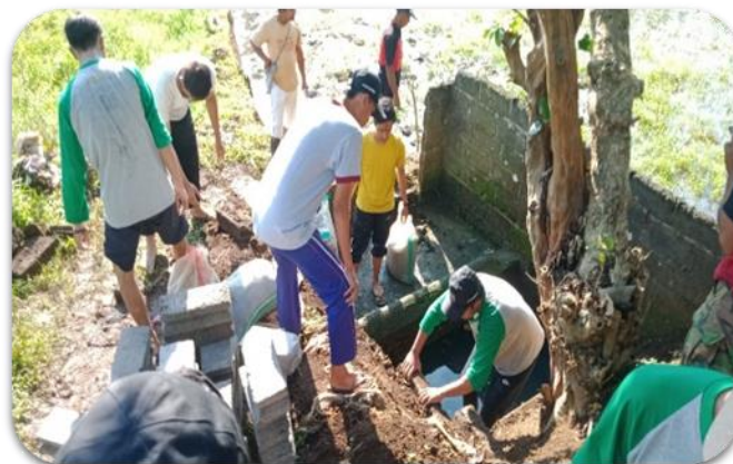
Gambar 2. Pemasangan tembok sumur
