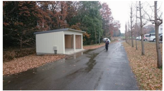
写真6 走行中給電仮設備
