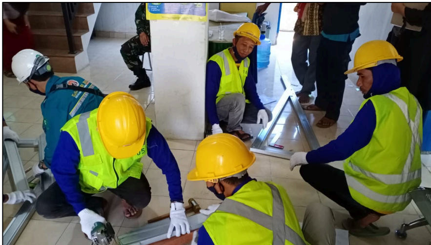
Gambar 5. Pelaksanaan kegiatan PKM (Praktik memotong dan merangkai rangka baja ringan)
