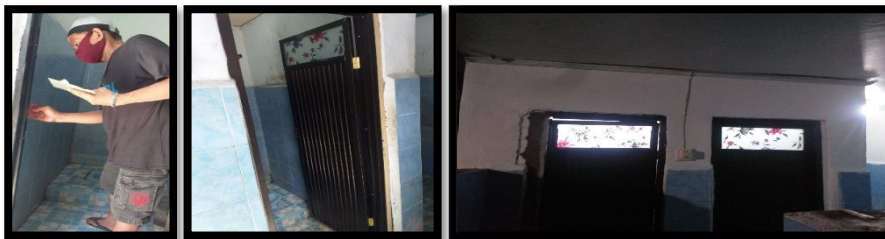
Gambar 3. Proses rehabilitasi terhadap pintu WC Umum
