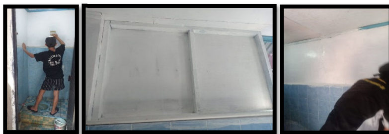
Gambar 4. Proses rehabilitasi terhadap dinding dan jendela
