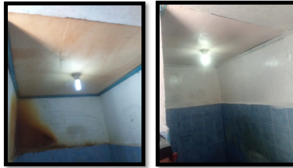
Gambar 5. Atap pelindung (plafond) setelah direhabilitasi
