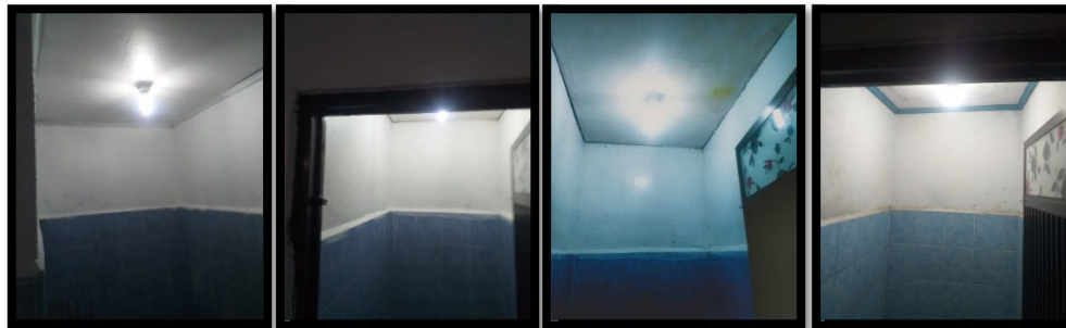
Gambar 6. prasarana penerangan yang telah direhabilitasi
