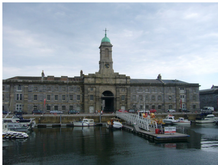
IMAGEN 1 - ROYAL WILLIAM YARD, PLYMOUTH. ANTIGUO PUERTO MILITAR RECONVERTIDO EN ÁREA COMERCIAL Y RESIDENCIAL
