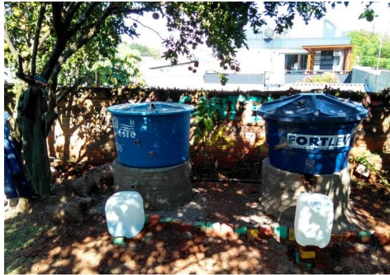
Figura 3 - Composteiras instaladas na APAE, ambos reservatórios de 250 litros.
