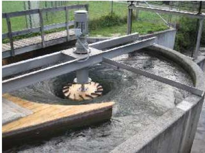
Abbildung 7: Gravitationswasserwirbelkraftwerk
