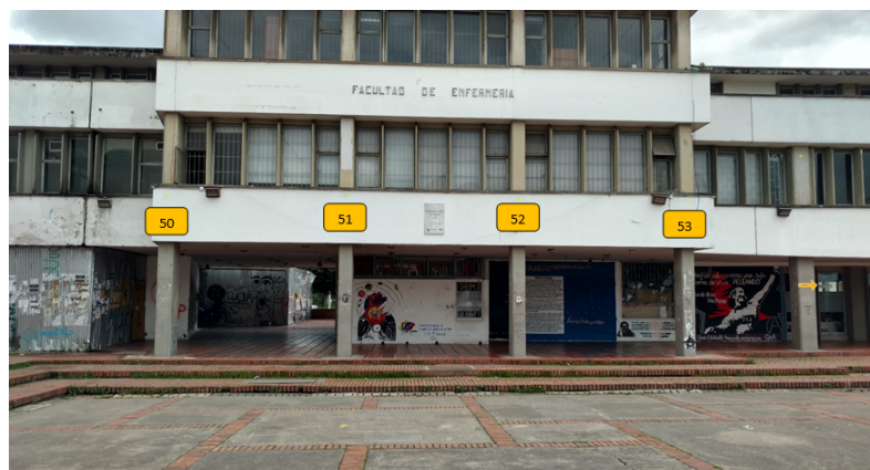
Figura 7: Puntos de control fachada norte.
