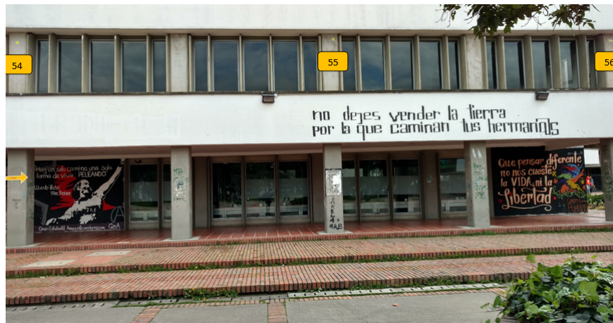
Figura 8: Puntos de control fachada norte.
