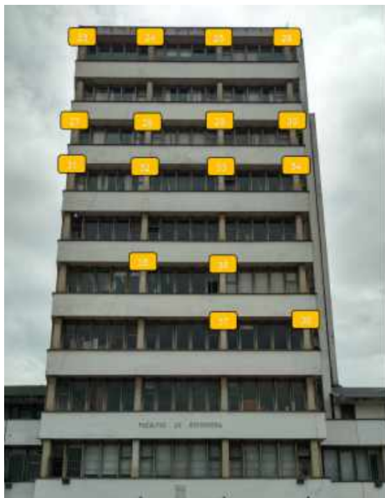
Figura 3: Puntos de control fachada norte.
