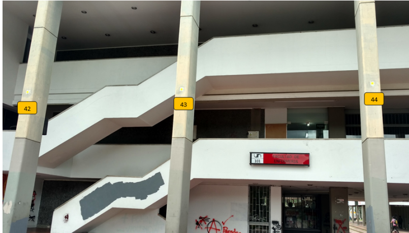
Figura 5: Puntos de control fachada sur.
