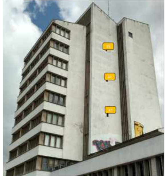
Figura 4: Puntos de control fachada occidental.
