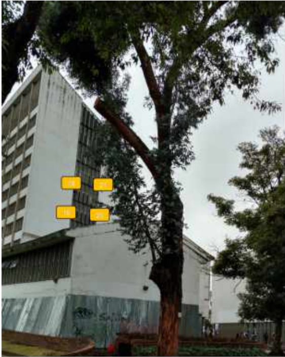
Figura 2: Puntos de control fachada oriental.
