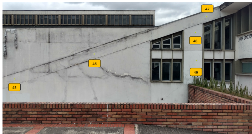
Figura 6: Puntos de control fachada suroccidental.
