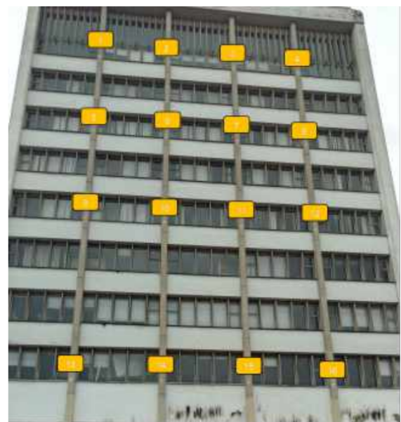
Figura 1: Puntos de control fachada sur.
