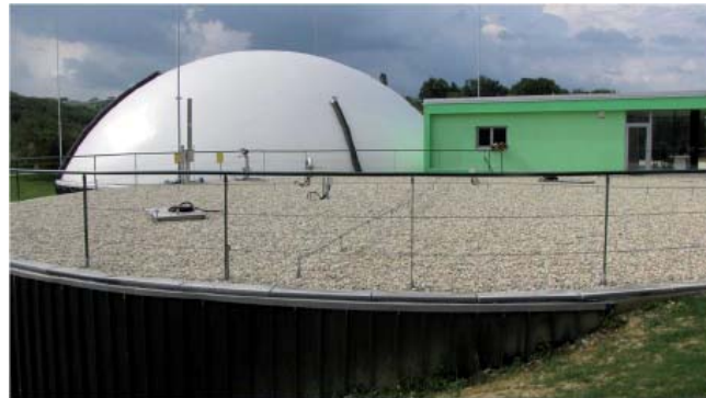
Pri Arnušu sta dva digesterja pokrita z betonsko ploščo, na tretjem digesterju pa je plinohram za bioplin.
