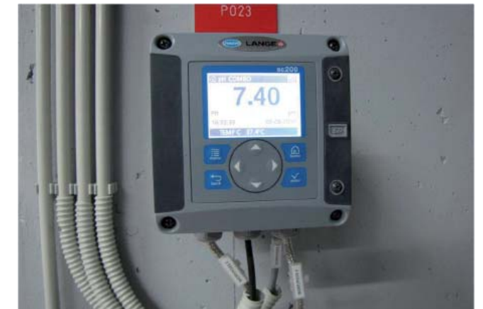
Danes si bioplinske naprave ne moremo predstavljati brez pH-metra, saj mora za pravilno delovanje anaerobne fermentacije obstajati ustrezno okolje. Na sliki je prikazan valnik pH-metra in temperature substrata v digesterju.
