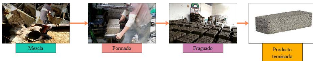
Figura 2 Proceso de fabricación de tabicón ligero.
