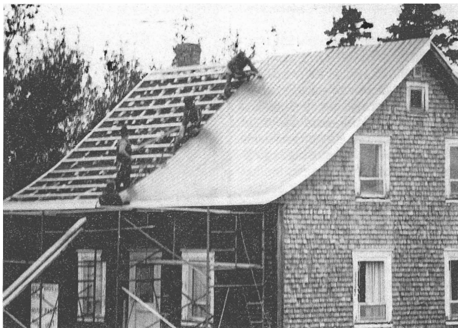
Travaux de restauration à l'été 1989.
