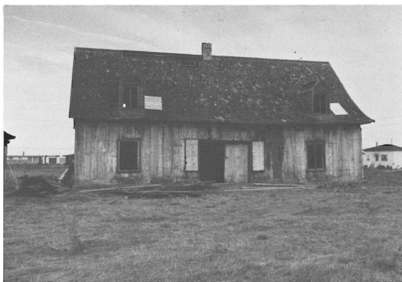
En cours de curetage (MAC).
