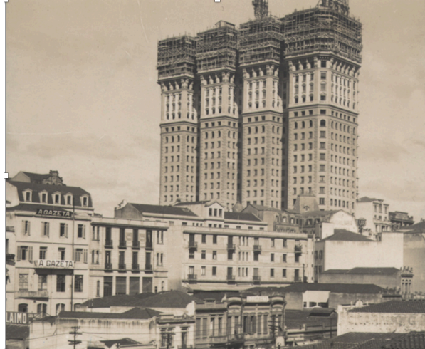
Figure 2.5 Predio Martinelli under construction, São Paulo, ca. 1926. (Source: Estadão. https://acervo.estadao.com.br/noticias/acervo.como-era-sao-paulo-sem-o-edificio-martinelli,9083,0.htm .)
