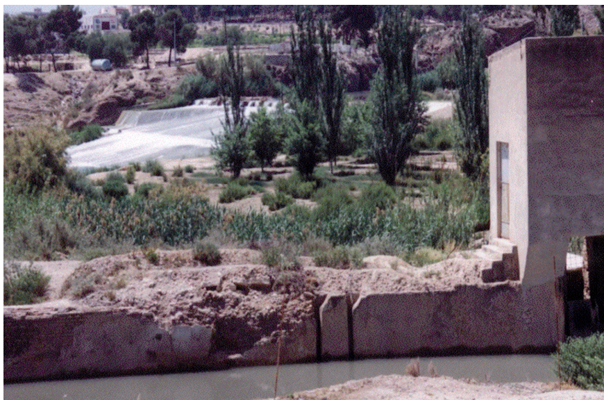
Fig. 4. Presa de La Contraparada. En primer plano, la Acequia Aljufia o «del norte».
