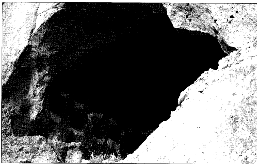
LÁMINA 7. La pared externa de la gruta que se ha hundido por las inclemencias de los tiempos.
