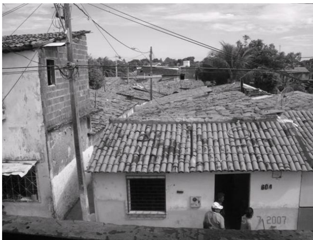
[Imagen 3. Casas construidas muy próximas unas a otras.]
